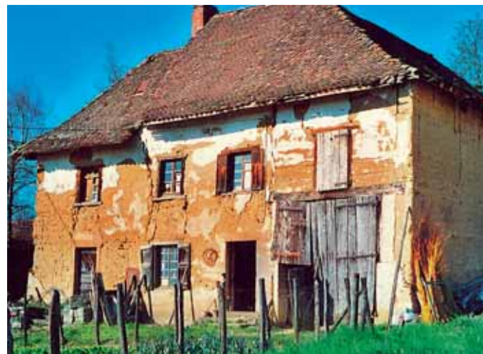
Habitation avec grange intégrée.
