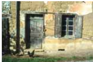
Quelques traces de l'enduit de chaux qui recouvrait initialement les façades en pisé.
